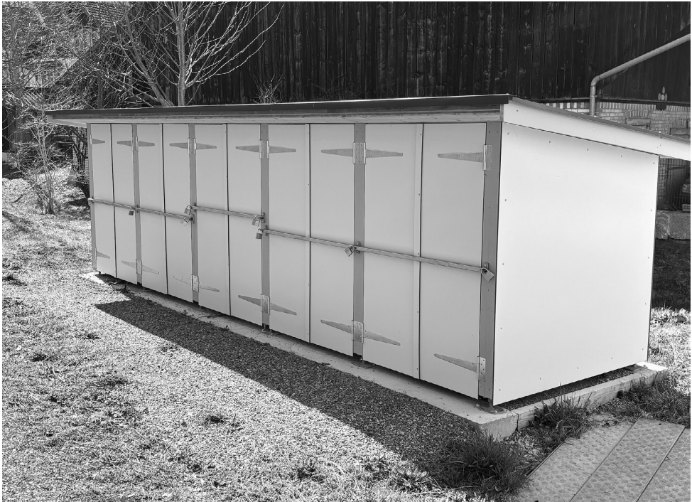
Interventionsmaterialstandort Furthstrasse Bichelsee
