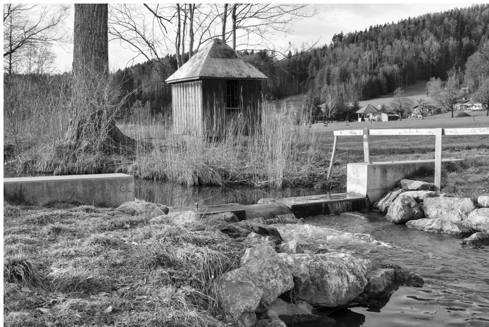
Auslauf Bichelsee mit Notablass Feuerwehr
