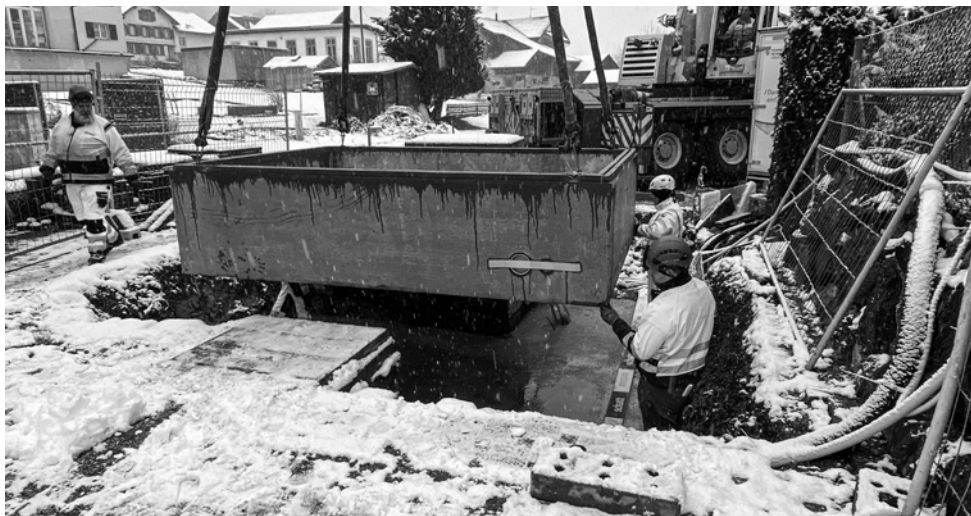
Versetzen Kabelkeller Transformatorstation Itaslen
