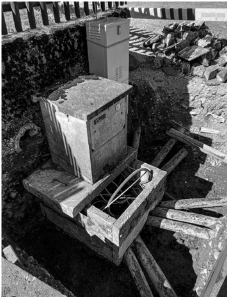
Ersatz Klemmkabine Alte Landstrasse in Itaslen
