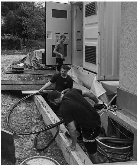
Umbauarbeiten Transformatorstation Dorf Bichelsee
