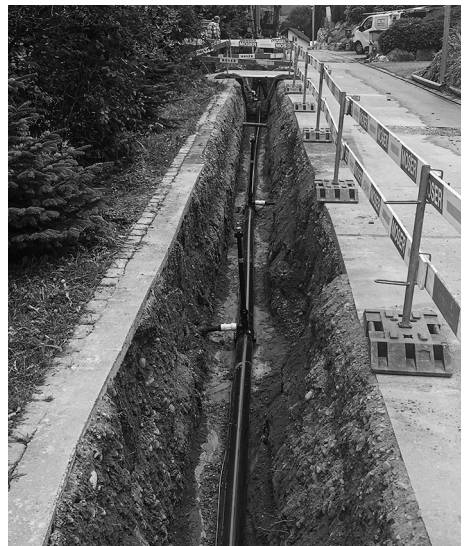
Ersatz Wasserleitung Haldenstrasse Balterswil
