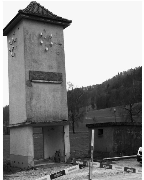
Abbruchbereite Transformatorstation und Pumpwerk Höfli
