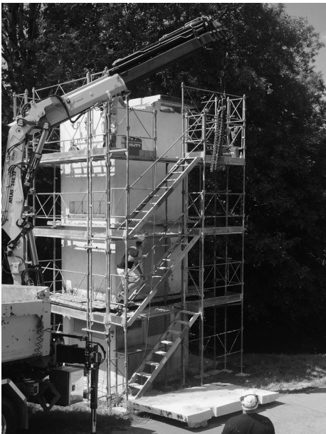
Teilrückbau Transformatorstation Steig
