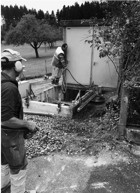
Unterhaltsarbeiten Station Loh
