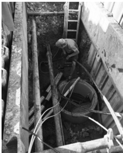
Werkleitungsumlegung Gebiet Hägler
