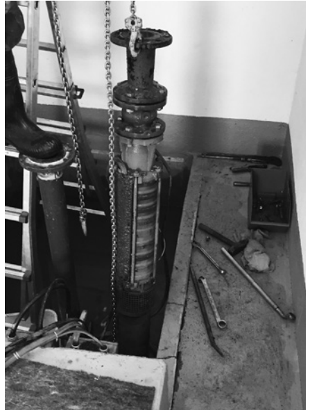
Rückbau der alten Infrastruktur.
