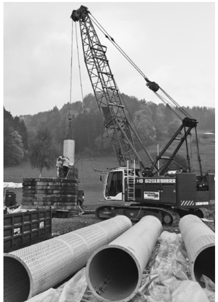
Einbau Filterrohr in den Brunnen.
