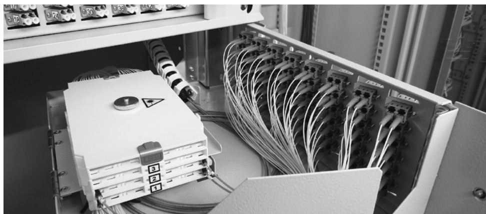
Baugruppenträger Glasfasernetz
