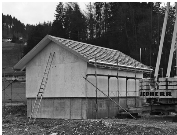
Gebäude Neubau Pumpenhaus Espriet.
