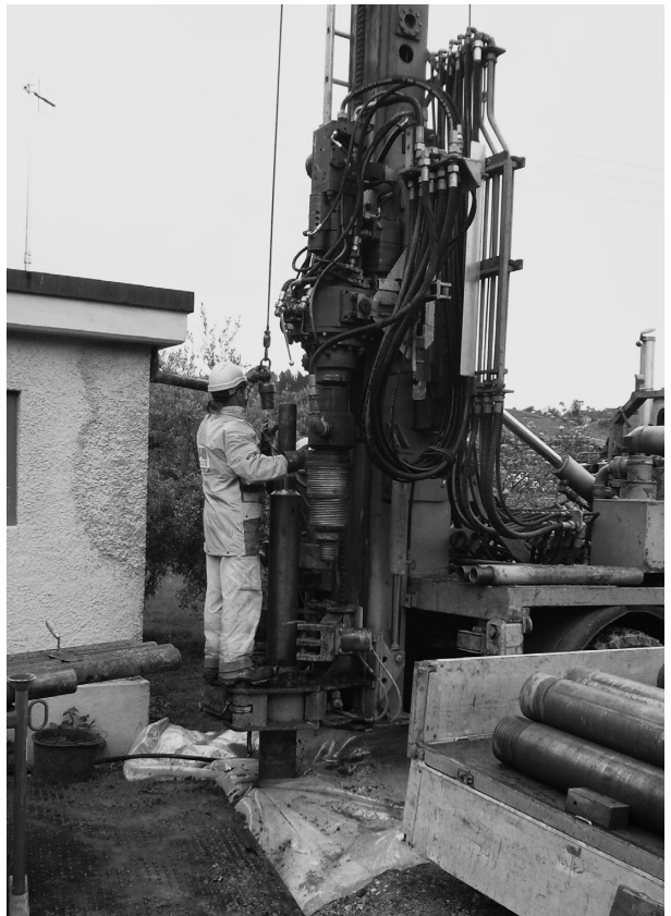
Sondierbohrung beim Espiriet
