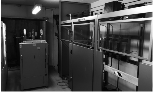
Umbau Messstation Schulzentrum
