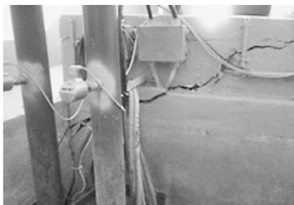
*Risse in der Betonkonstruktion im Pumpenhaus*
